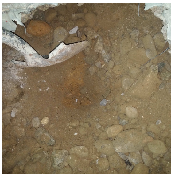
Foto massiciata di sottofondo pavimento mensa
