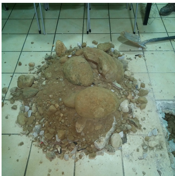
Foto massiciata di sottofondo pavimento mensa
