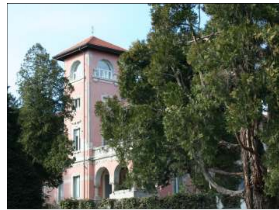
edificio 7 - Villa Ughetta
