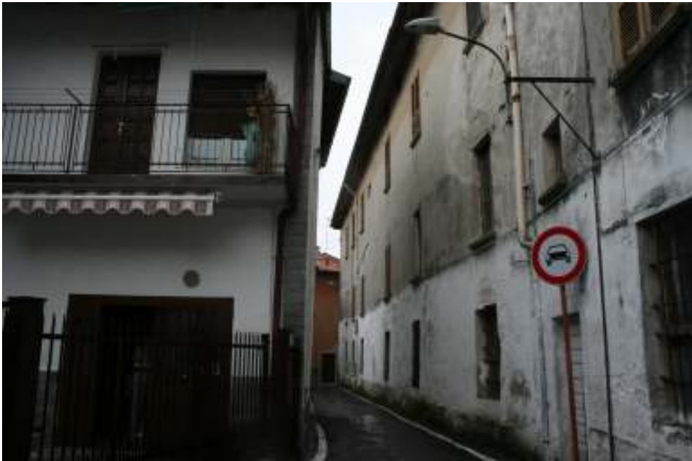
Isolato via Genova
