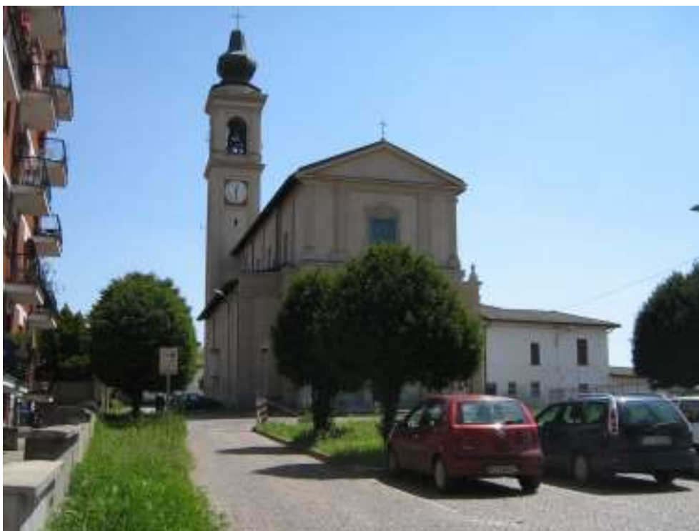
Il prospetto nord di S. Maria Assunta e gli edifici intorno
