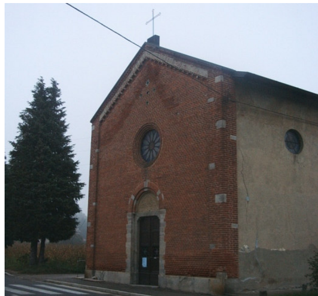
foto 1 - prospetto principale su via Roma
