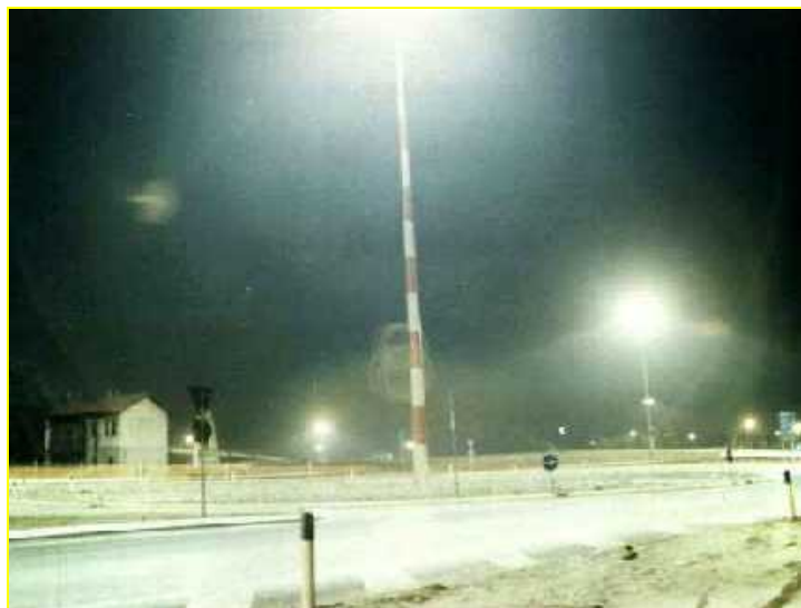
Figura 24.10 – Svincolo di Malpensa 2000 - Impianto di grande impatto luminoso progettato con corpi distribuiti su 3 anelli, a 45° verso il basso, orizzontali e puntati a 45° verso l'alto. E' visibile da 30 km di distanza ed i 2/3 della luce viene usata per illuminare il cielo (S. Minuto).
